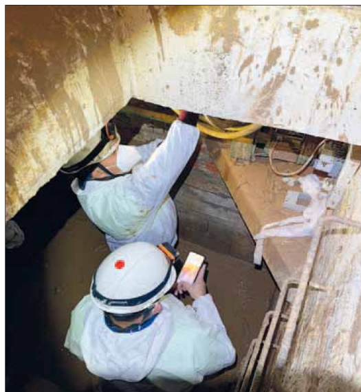
SERVICIO. Arreglos a la bomba de empuje del agua potable.
