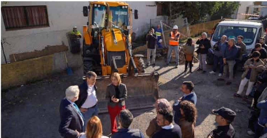
La alcaldesa de Jerez de la Frontera (Cádiz), María José García-Pelayo, junto al delegado del Gobierno en Andalucía, Pedro Fernández, supervisan las obras que está ejecutando el Ayuntamiento de Jerez, a tra
