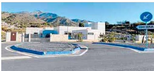
La planta de tratamiento de las aguas residuales de Nerja. E. CABEZAS
